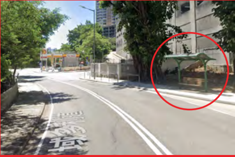
Victoria Road Sitting-out Area 域多利道油站旁休憩處
