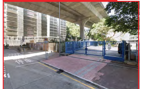
Butterfly Valley Road Pet Garden, Lai Chi Kok 荔枝角蝴蝶谷道寵物公園
